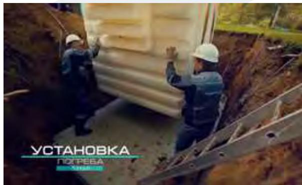
С помощью спецтехники опустить погреб в котлован и выровнять его относительно бетонной плиты и тросов.
